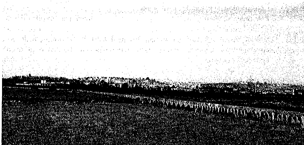
Al principio las acequias como la que se ve, se construyeron con hormigón "in situ"
