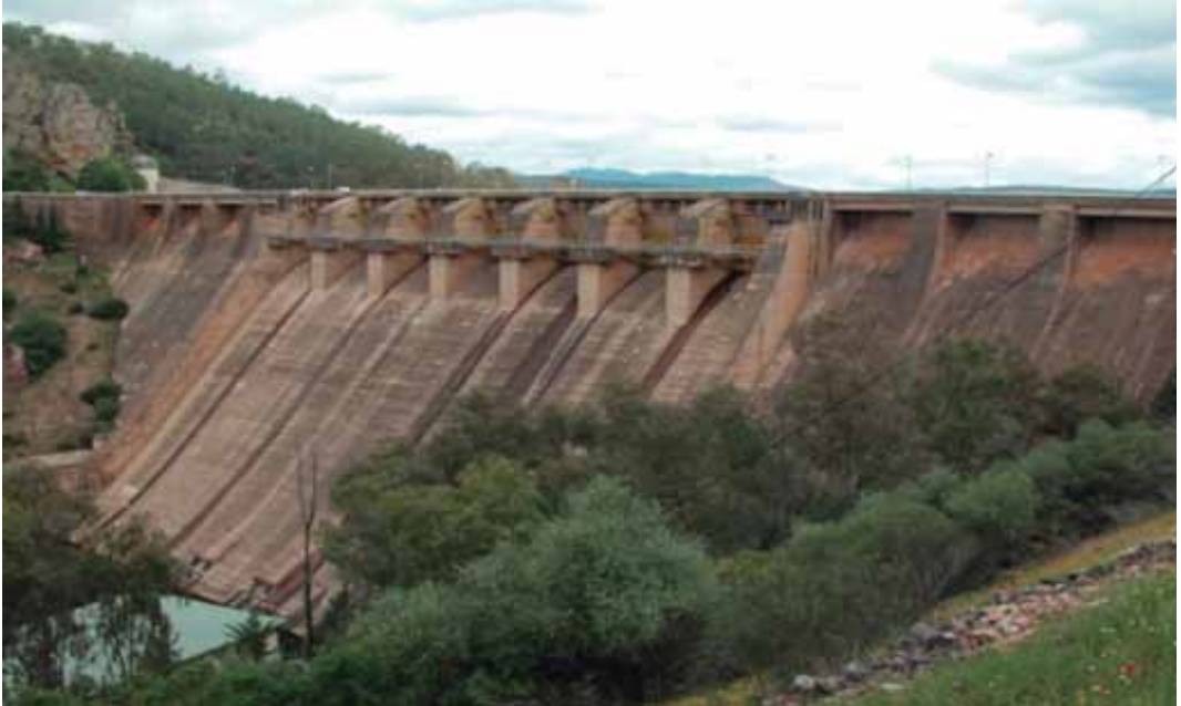
Presa de Cijara.
