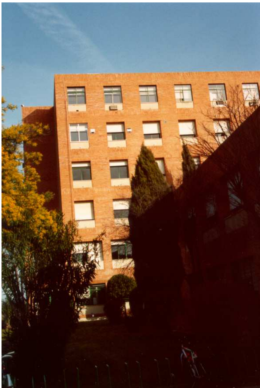
Figura IV: Edificio de Ciencias Químicas
