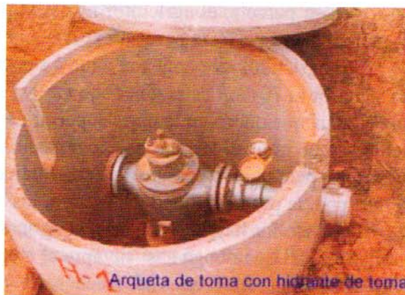
Antiguo hidrante del Sector E1° de Montijo. Se ve el contador proporcional abierto. Hoy hay otros modelos.
