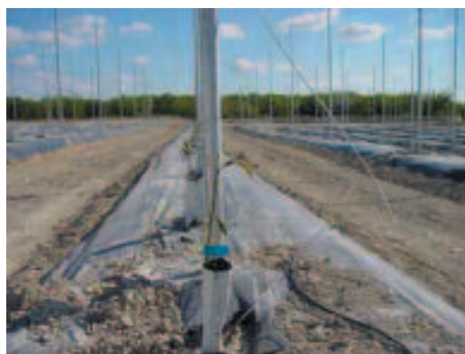
Fotografía 3. Plantación de mandarinos en 2005. Invernáculo en construcción
