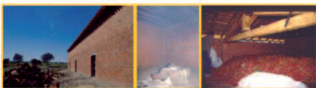
FIGURA 1: Imagen del exterior de un secadero de corriente vertical (izquierda), del hogar de leña (centro), y del piso superior donde se cargan los pimientos.
