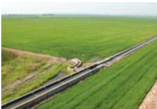
FOTO 5: Cultivos de Arroz. Impermeabilización de acequia en juntas con lámina de hypalon
