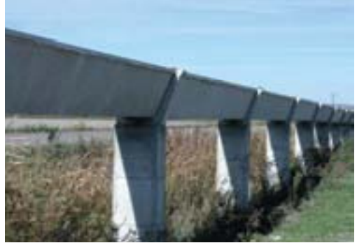
FOTO 2: Acequia prefabricada de alta estanqueidad en la Comunidad General de Orellana
