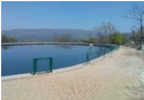
FOTO 3: Balsa de acumulación para riego. Zona de Gargantilla
