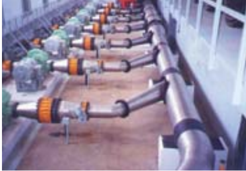
FOTO 1: Mejora de calderería con acero inoxidable. Comunidad de Regantes del Zújar
