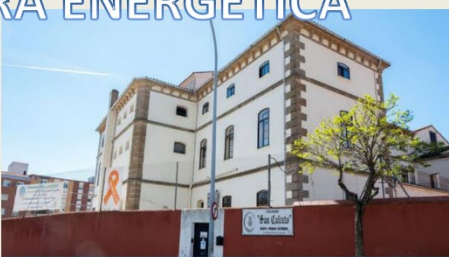
-Cambio de la antigua carpintería metálica -Sectorización de los espacios
