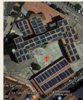
Instalaciones de placas solares fotovoltaicas
