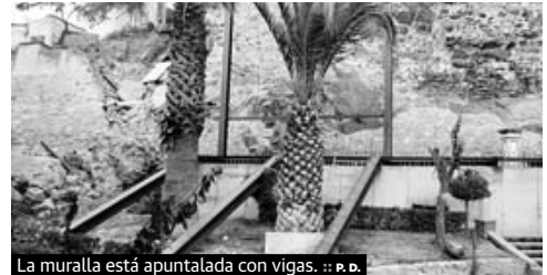
La muralla está apuntalada con vigas. •• P. D.
